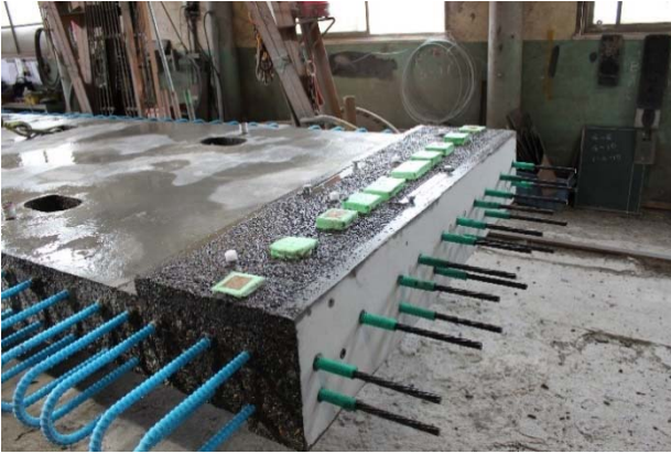
写真-6 レイトンス処理完了
