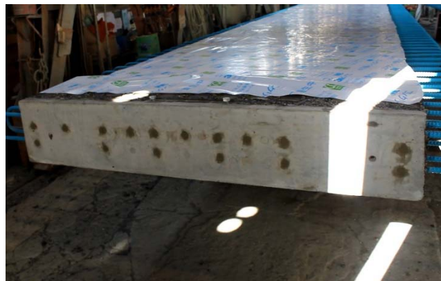
写真-22 仕上げ材による後埋め完了
