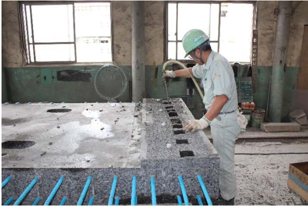
写真-10 切断孔内の清掃状況
