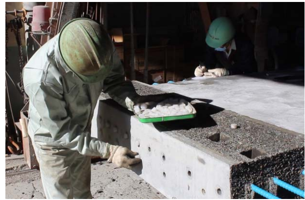
写真-13 プラスチック栓の設置状況
