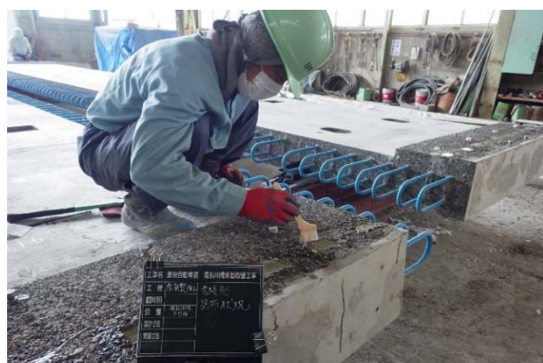
写真-23 表面含浸材の塗布
