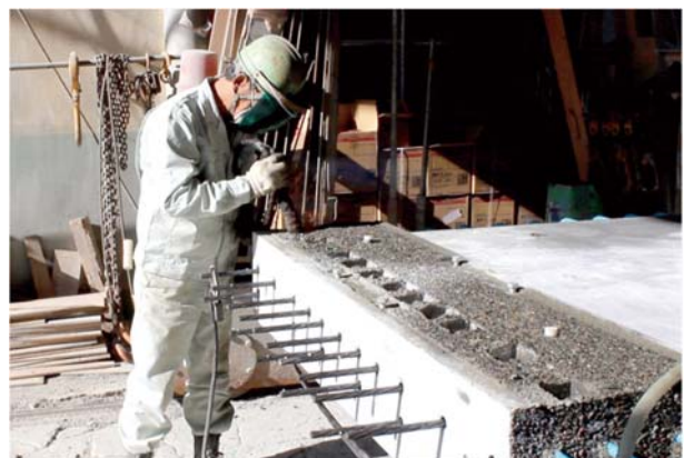
写真-9 PCケーブルの切断・撤去
