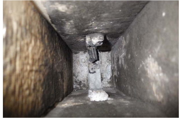
写真-11 切断孔内の清掃完了後
