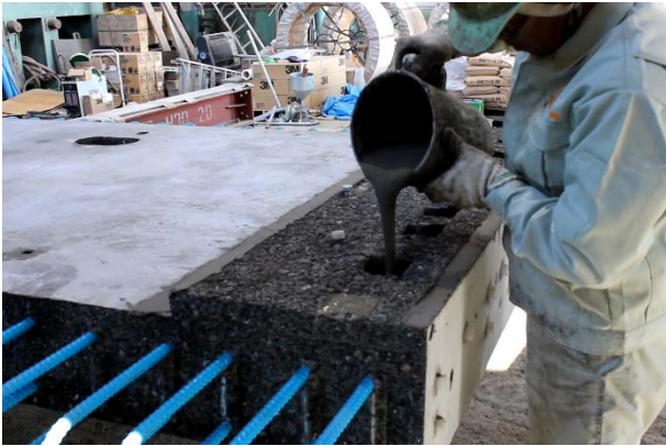
写真-15 無収縮モルタルの充填状況
