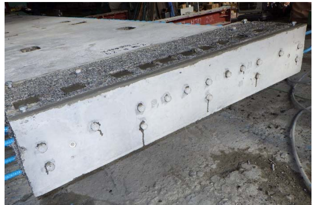
写真-16 無収縮モルタルの充填完了
