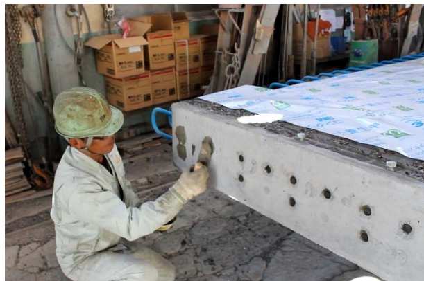
写真-21 仕上げ材による後埋め
